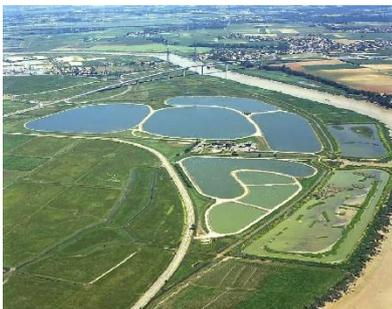
Site unique en France, la station de lagunage de Rochefort est un exemple de gestion performante de l'environnement. Cette station permet de traiter de façon économique et écologique l'ensemble des eaux usées de l'agglomération rochefortaise. Elle est également autonome en énergie grâce à la valorisation du méthane par co-générateur en électricité. Ce site est aussi un lieu remarquable pour
