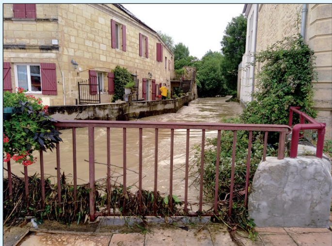
Pont de la Pimpine à Latresne : goulet d'étranglement de l'écoulement de la Pimpine.
