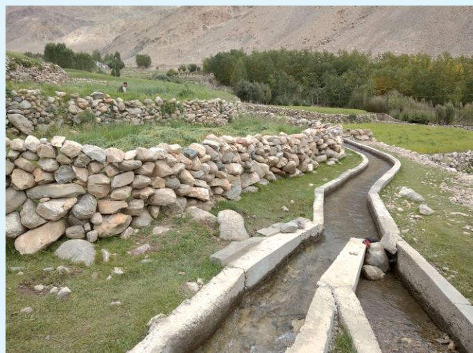
Système de canalisation de l'eau (mayur) cimenté à 4 100 mètres d'altitude avec des terrasses étagées pour la culture de l'orge et talus d'éboulis de gélifraction. Au fond à droite, végétation arborée autour du talweg d'une rivière. © Olivier Chiron
