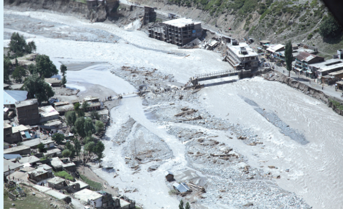
Pont détruit lors de l'inondation de 2010.
