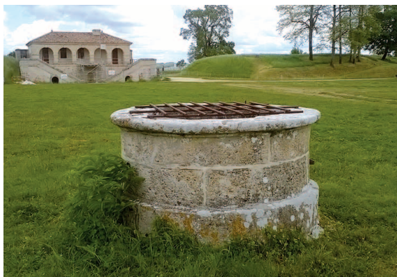
Puits de Cussac-Fort-Médoc, Gironde © Eric Veyssy
